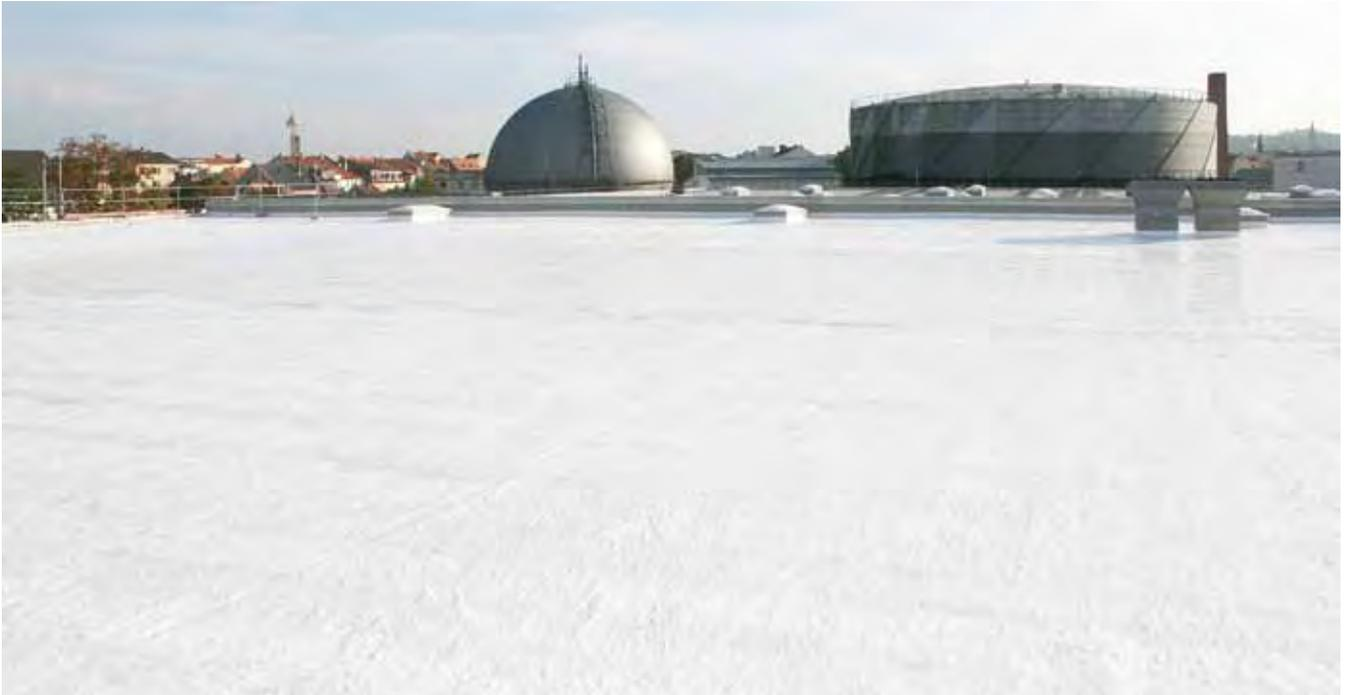
Als schneeweiße ebene Fläche erstreckt sich das Dach der Stadtwerke Bamberg, nachdem die Fläche saniert und mit Triflex ProTect abgedichtet wurde.
