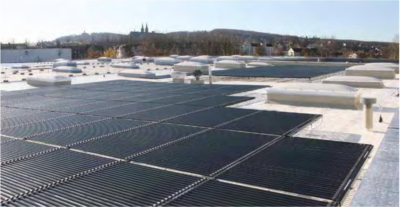
Auch Anschlüsse, Details und Lichtkuppeln lassen sich nahtlos mit Triflex Flüssigkunststoff abdichten.
