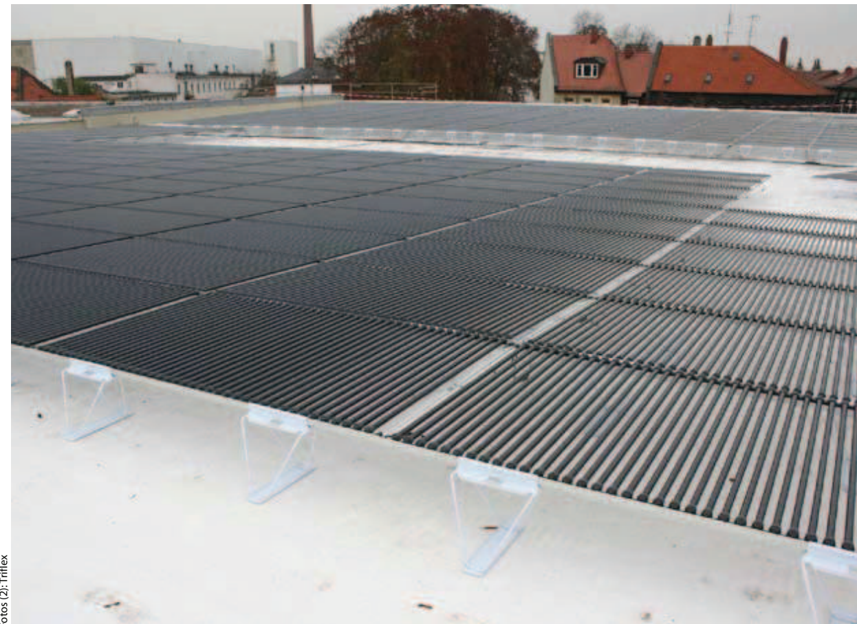
Aus dem hohen Rückstrahlverhalten der weißen Dachbeschichtung resultiert ein besserer Energieerzeugungseffekt, der sich positiv auf den Ertrag auswirkt.
